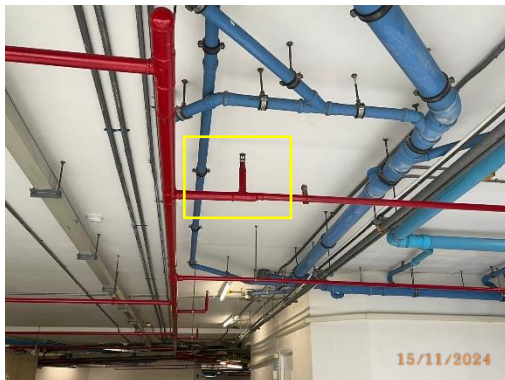
รูปที่ 44 ระบบหัวกระจายน้ำดับเพลิง
