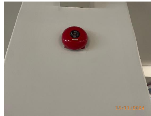
รูปที่ 54 อุปกรณ์ส่งสัญญาณแจ้งเหตุอัคคีภัย
