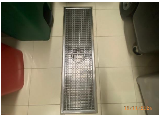
รูปที่ 34 ท่อรวบรวมน้ำเสียในห้องพักรมูลฝอย
