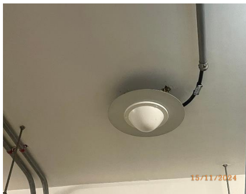
รูปที่ 52 เครื่องจับความร้อน (Heat Detector)
