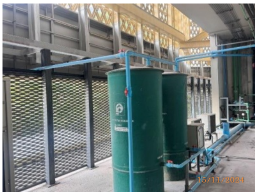
รูปที่ 19 ระบบกำจัดก๊าซมีเทนสำเร็จรูป
