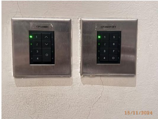
รูปที่ 95 เครื่องปรับระดับแสงสว่าง (Dimmer)
