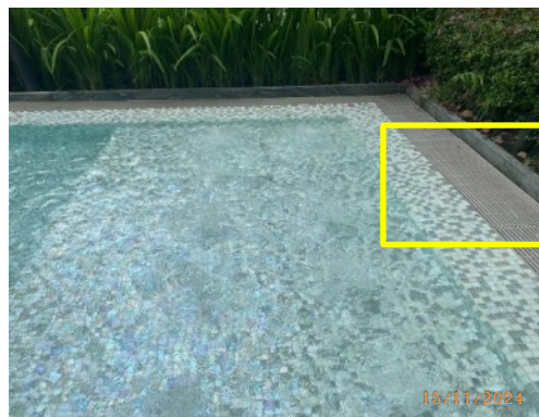
รูปที่ 74 รางระบายน้ำล้นของสระว่ายน้ำ
