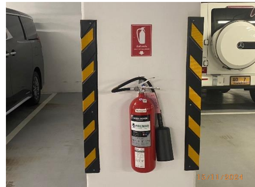
รูปที่ 45 ถังดับเพลิงเคมี
