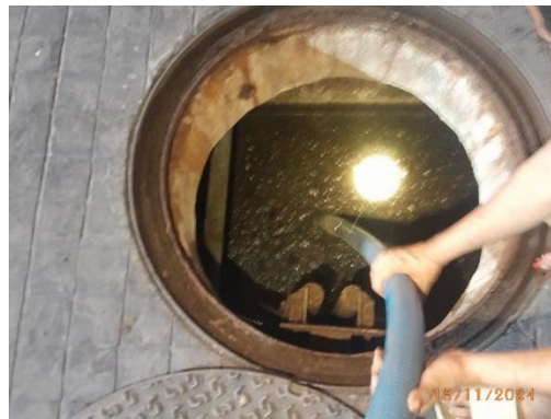
รูปที่ 20 การสูบลากตะกอนส่วนเกินของโครงการ
