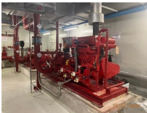
รูปที่ 46 เครื่องสูบน้ำดับเพลิง
