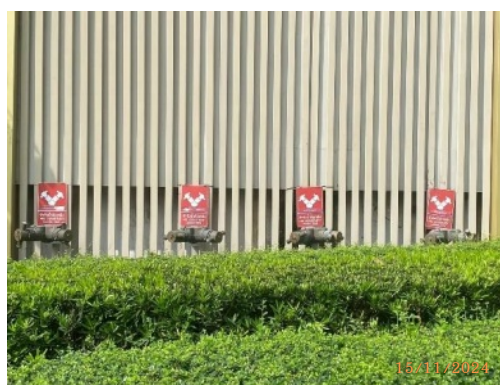
รูปที่ 42 หัวรับน้ำดับเพลิงภายนอกอาคาร
