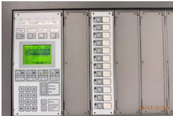
รูปที่ 50 ระบบควบคุมแจ้งเตือนเพลิงไหม้ (Fire Alarm control Panel:FACD)
