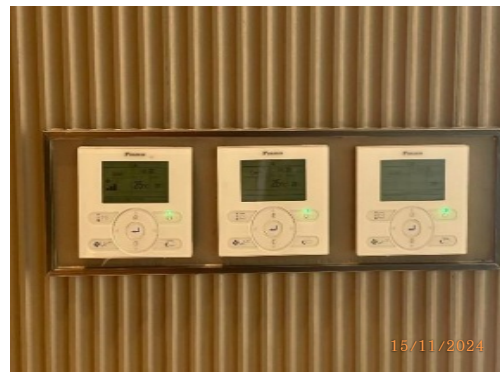
รูปที่ 38 เครื่องตั้งอุณหภูมิภายในโครงการให้มีค่า 25 °C
