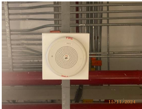
รูปที่ 54 อุปกรณ์ส่งสัญญาณแจ้งเหตุอัคคีภัย
