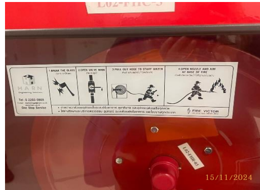
รูปที่ 43 ตู้เก็บสายฉีดน้ำดับเพลิง และป้ายแนะนำการใช้อุปกรณ์
