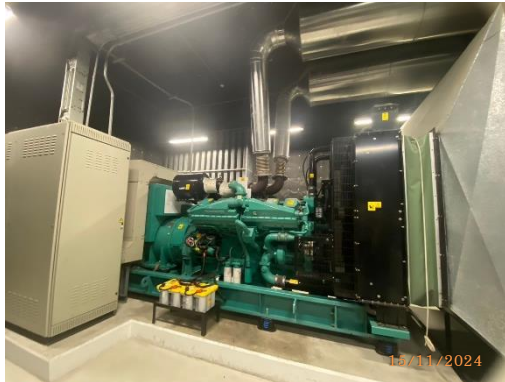
รูปที่ 57 เครื่องกำเนิดไฟฟ้าสำรองของโครงการ
